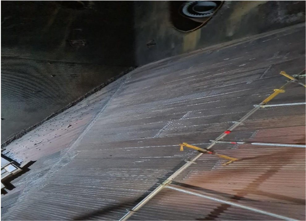
Слика. 2 Унутрашњост испаривача (екрана)
